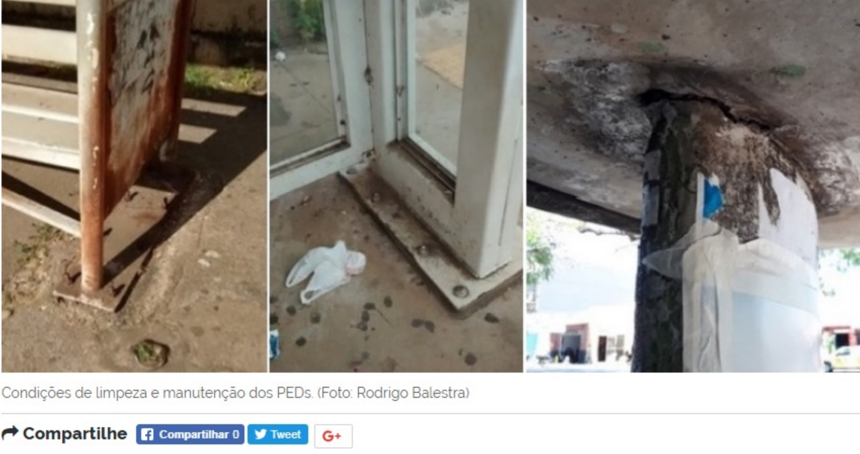
Condições de limpeza e manutenção dos PEDs. (Foto: Rodrigo Balestra)
