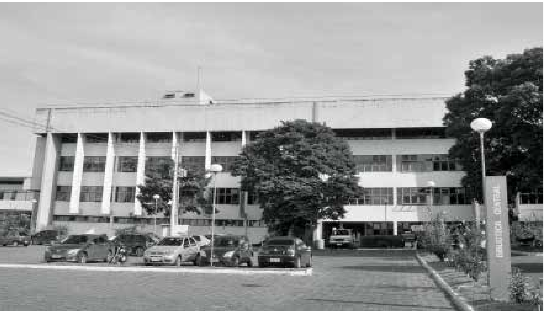
Biblioteca Central, no Câmpus Samambaia, construída com recursos do programa MEC/BID III
