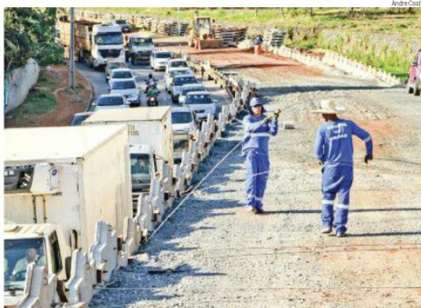
Ontem, na retomada das obras, a movimentação de operários e máquinas ainda era pequena
