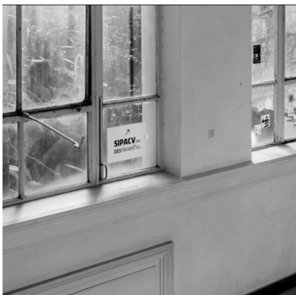
Fig. 2, 3 e 4. Desirée Ferreira: Gente en obra , 2025.
