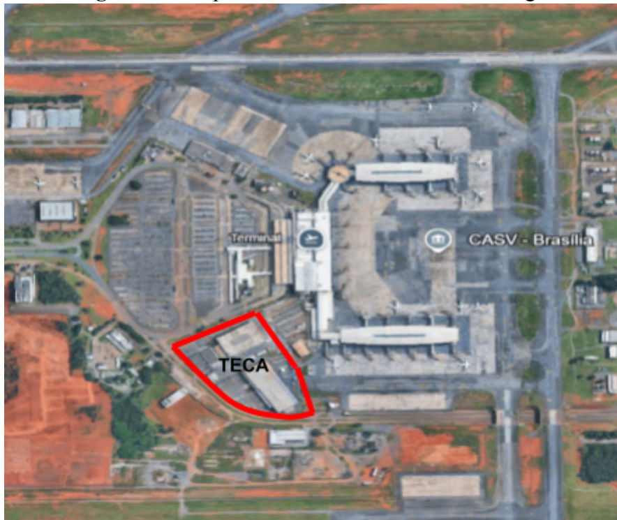
Figura 7. Aeroporto de Brasília - Terminal de Cargas
