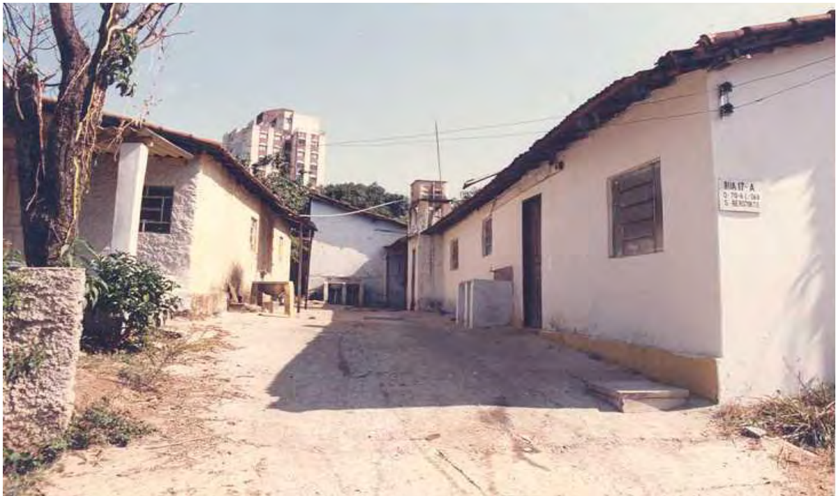
Figura 2 - Casa Rua 17-A
