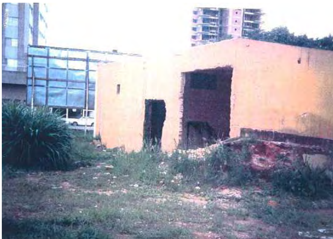
Figura 1 - Escombros do Instituto Goiano de Radioterapia
