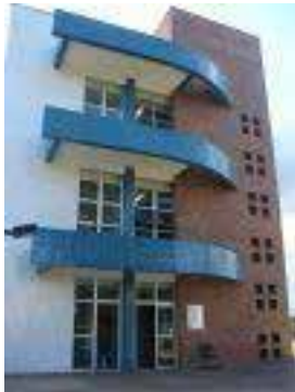
Figura 2: Fotografia do prédio da FACE/UFG
