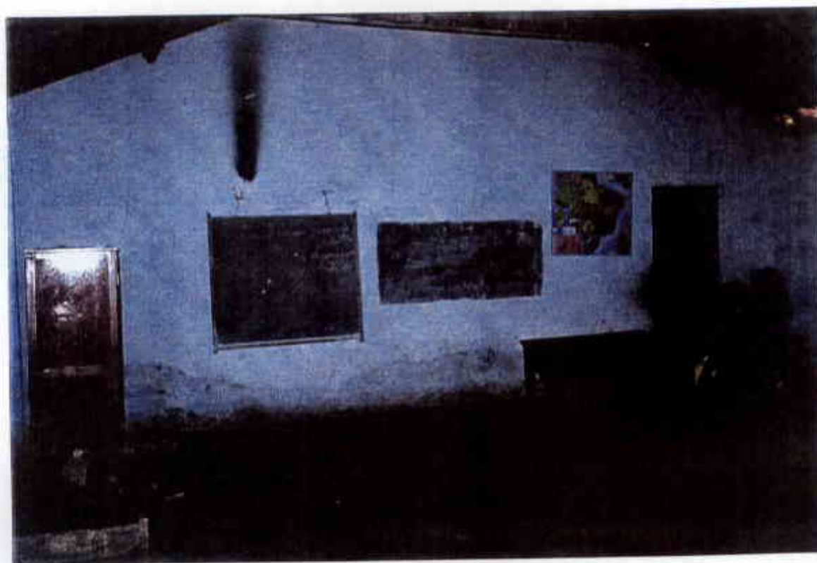
Foto 9. Escola Municipal Rural Extrema
