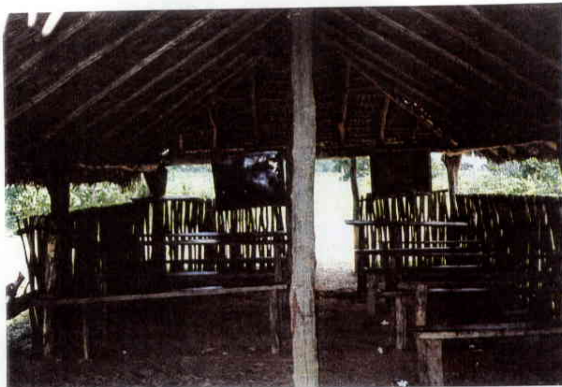
Foto 12. Escola Municipal Rural Barra do Palmeiras
