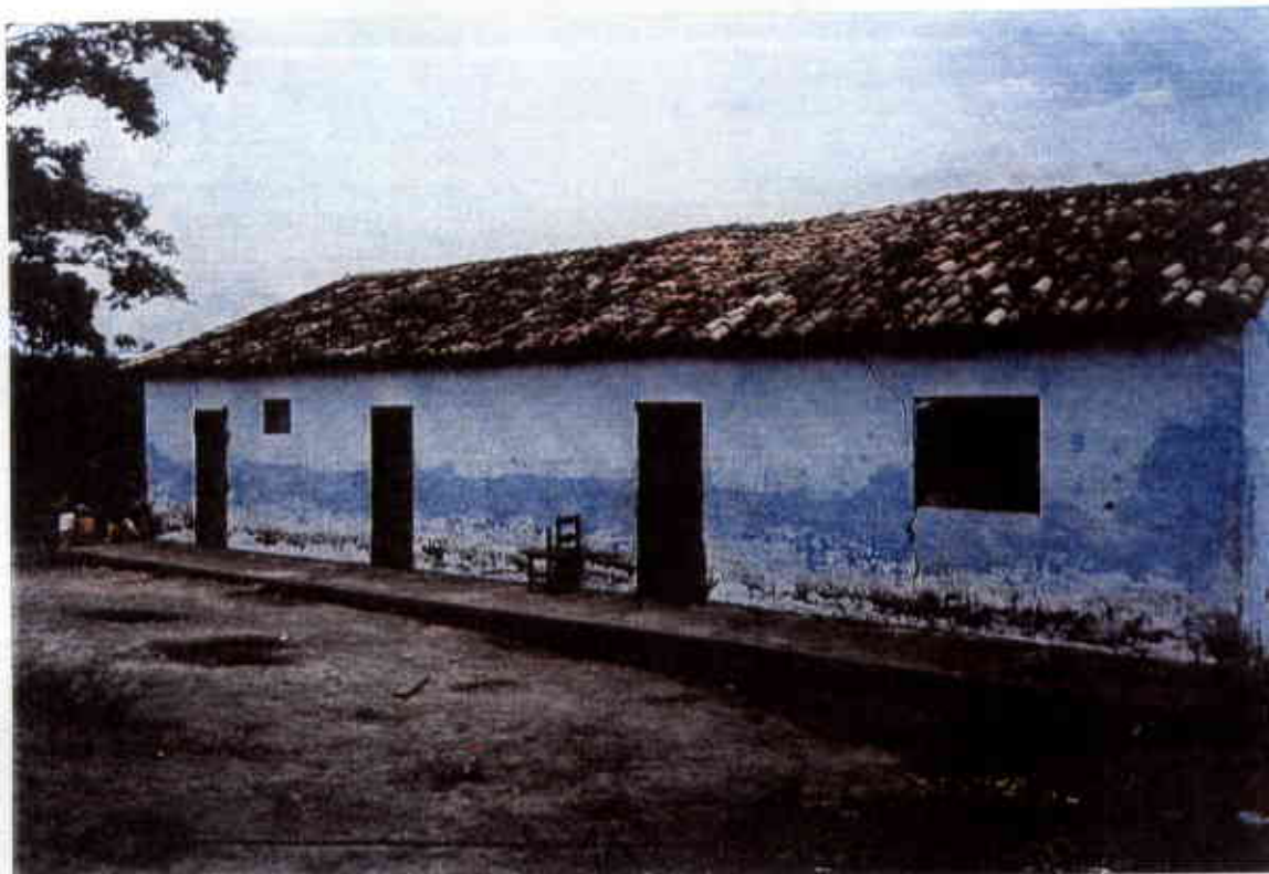
Foto 3. Escola Municipal Rural Extrema
