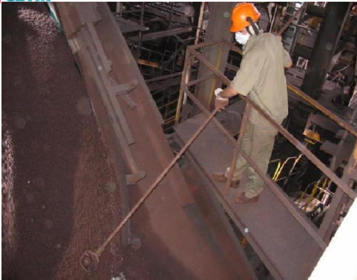
Limpeza interna nos discos
