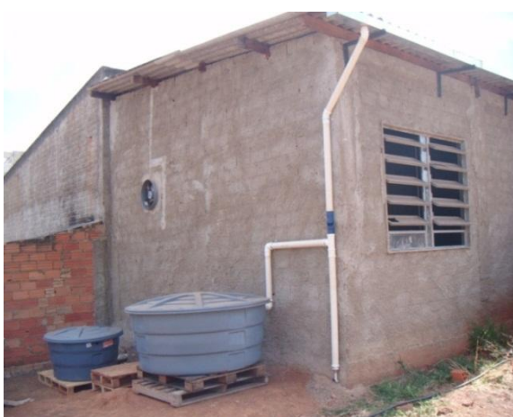
Figura 2 – Montagem do sistema de aproveitamento de águas pluviais com suas etapas.
