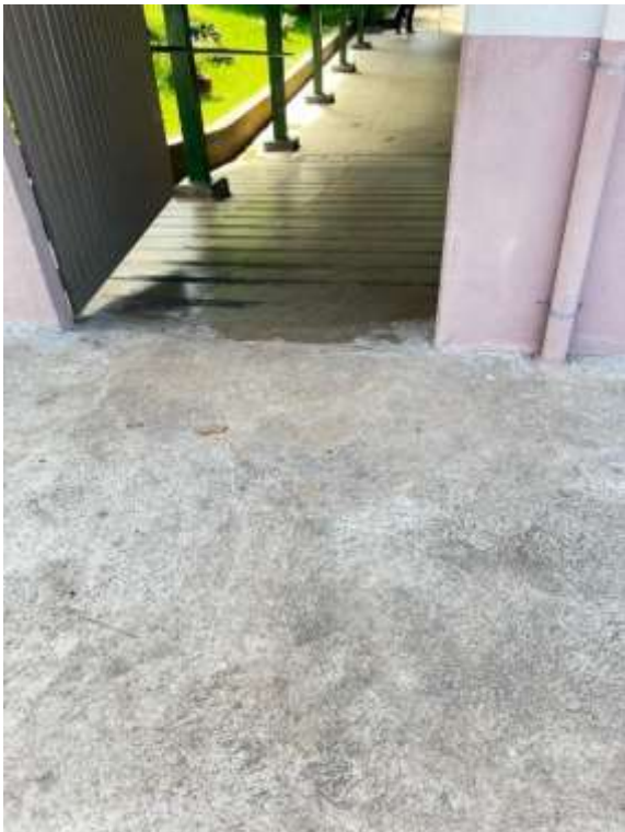
Figura 1 - Vista externa da rampa de acesso da entrada da escola
