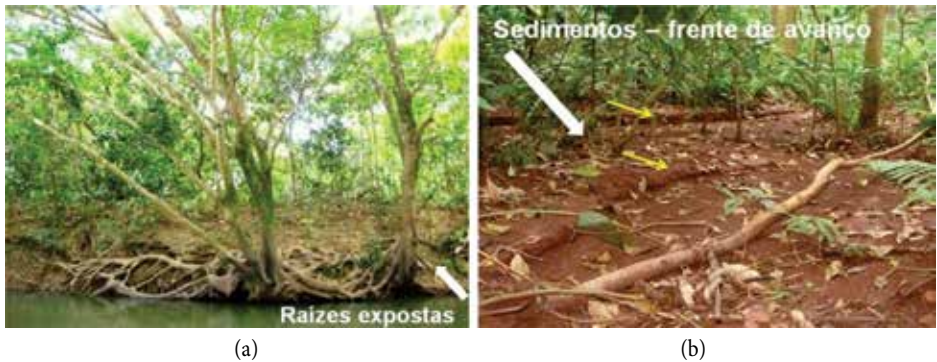
Figura 29. Processo erosivo em margem de corpo hídrico, evidenciado pela exposição de raízes de indivíduos arbóreos (a) (Foto: Renata S. Momoli). Processo erosivo em mata ciliar, evidenciado pelo soterramento de caules de indivíduos arbóreos (b) (Foto: Miguel Cooper).
