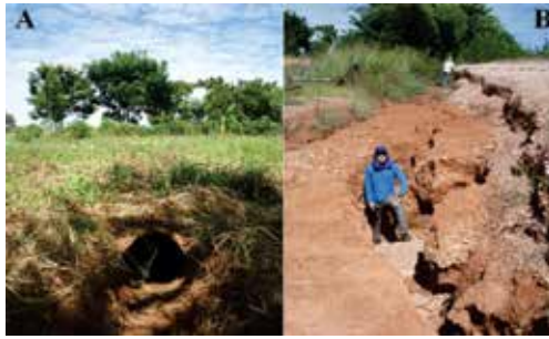
Figura 14. Lançamento das águas pluviais (A); erosão causada pelo mesmo (B). Fonte: Maurício Martines Sales (2014).
