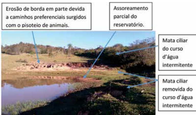
Figura 6. Reservatório em área rural de Bonito, MS (Foto: José Camapum de Carvalho, 2016).
