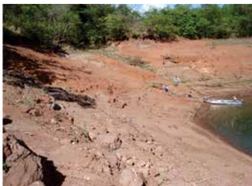
Figura 10. Erosão ocasionada pelo choque das ondas do reservatório de Furnas.
