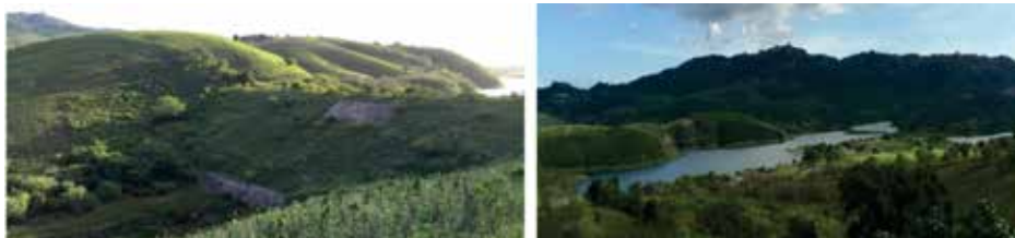
Figura 4. Barragem José Rodrigues.
