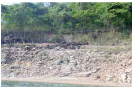
Figura 5. Erosão na margem do reservatório de Itumbiara. (Foto: Maurício Martines Sales).
