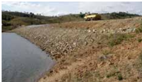
Figura 2. Construção do talude de montante, Barragem Saulo Maia.
