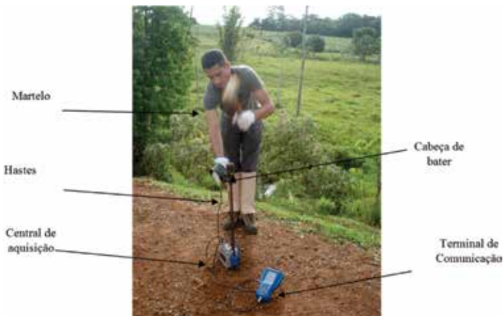
Figura 8. Execução de ensaio PANDA2. Foto: Maurício M. Sales (2012).
