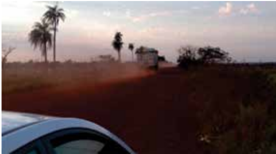
Figura 25. Erosão eólica gerada pela passagem de veículos; rodovia MS178, trecho que liga Bonito à BR 267, MS (Foto: José Camapum de Carvalho).
