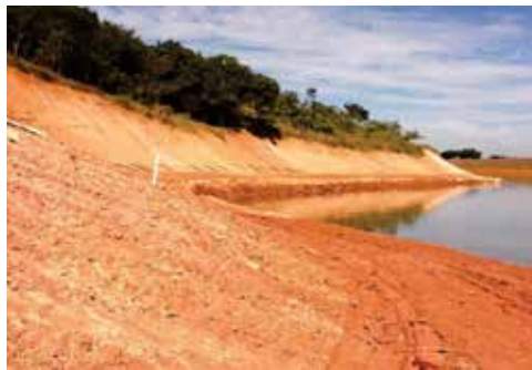
Figura 16. Suavização de talude na borda do reservatório da UHE-Furnas (MG). Foto: Maurício Martines Sales (2013).
