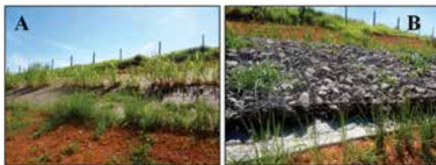
Figura 17. Proteção de vertente com geossintético e capim-vetiver (A) e com colchão de reno (B) na borda do reservatório de Furnas.
