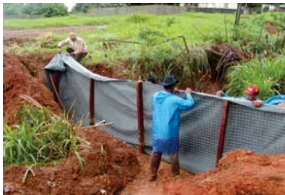
Figura 21. Instalação de geotêxtil não tecido em barreira de contenção planar (Foto: FARIAS, 2005).
