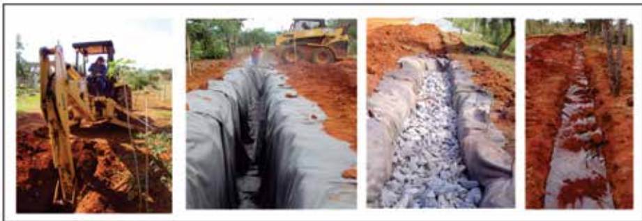
Figura 4. Detalhe das etapas de construção de trincheiras: (a) escavação da vala, (b) colocação de manta para proteger o material drenante da trincheira, (c) preenchimento da trincheira com material poroso e em (d) envelopamento da trincheira pronta.
