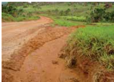
Figura 13. Colocação de curvas para redução do comprimento de encostas como estratégia para controlar a erosão (Foto: Wilson Conciani).
