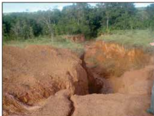
Figura 9. Voçoroca desenvolvida devido ao mau dimensionamento do vertedouro de uma barragem de propriedade particular próxima ao reservatório da UHE de Batalha.
