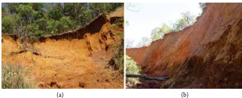
Figura 26. a) Talude em solo predominantemente amarelo; b) Talude em solo predominantemente vermelho (Fotos: José Camapum de Carvalho, 2007).
