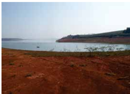
Figura 12. Margem exposta após rebaixamento da UHE de Furnas, com sinais de início de ravinamento. Fonte: Maurício Martines Sales (2015).
