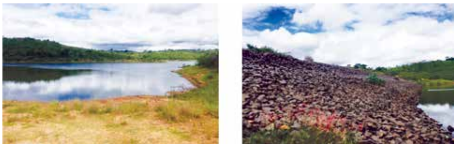
Figura 8. Barragem Sindô Ribeiro.
