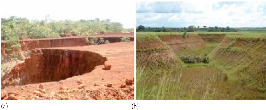
Figura 1. Área de empréstimo, UHE de Itumbiara: antes da recuperação (a); depois de recuperada (b). Fotos: Maurício Martines Sales (2012).
