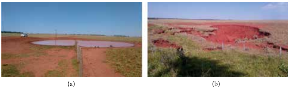
Figura 16. Bacias de detenção: (a) Via de acesso ao Recanto Ecológico Rio da Prata, Jardim-MS, a partir da BR 267 (Foto: Wilson Conciani); (b) Margem da rodovia MS178 no trecho que liga Bonito à BR 267 (Foto: José Camapum de Carvalho).
