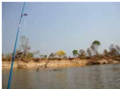
Figura 4. Erosão na margem direita do Rio Araguaia. (Foto: José Camapum de Carvalho).
