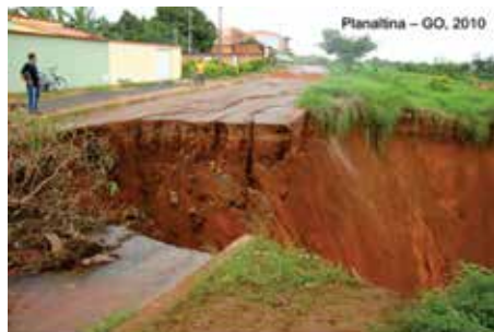
Figura 2. Erosão em Planaltina de Goiás. (Foto: José Camapum de Carvalho).
