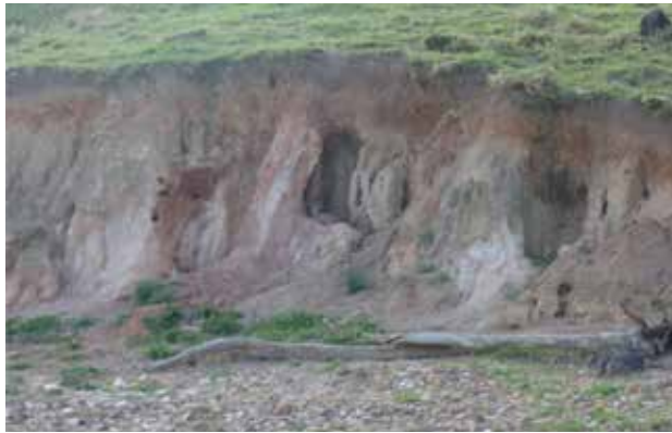
Figura 11. Erosão de borda no reservatório UHE Itumbiara. (Foto: arquivo pessoal de Maurício Martines Sales).
