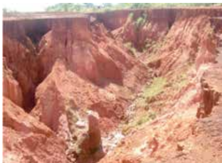
Figura 11. Área de empréstimo usada na construção da Barragem da UHE Itumbiara (Foto: Maurício Martines Sales).
