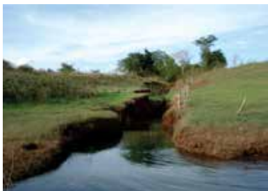
Figura 8. Erosão de margem de reservatório. (Foto: Maurício Martines Sales).
