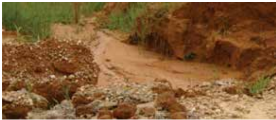
Figura 19. Dissipador de energia com uso de pedras (Foto: Wilson Conciani).
