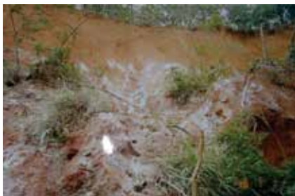
Figura 25. Erosão sendo calcarizada e adubada (1998).
