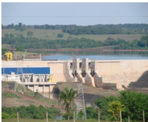
Barragem UHE Caçu
