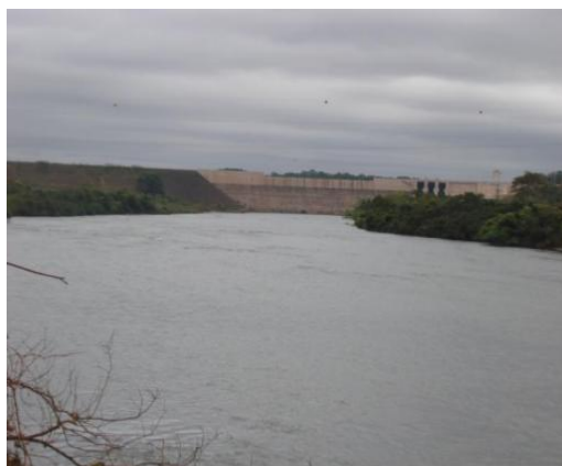
Barragem UHE Barra dos Coqueiros
