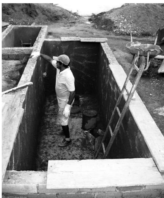
Hipermeabilização das paredes
