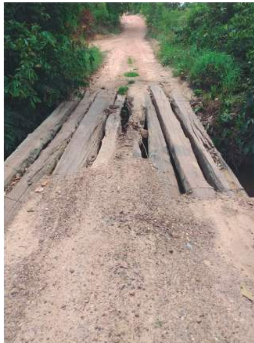
Ponte de madeira sobre o córrego Fundo, Arraial da Barra, 2019
