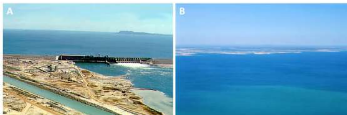
Figura 8. A) Barragem da Usina Hidrelétrica de Sobradinho; B) Vista aérea do lago da UHE de Sobradinho.
