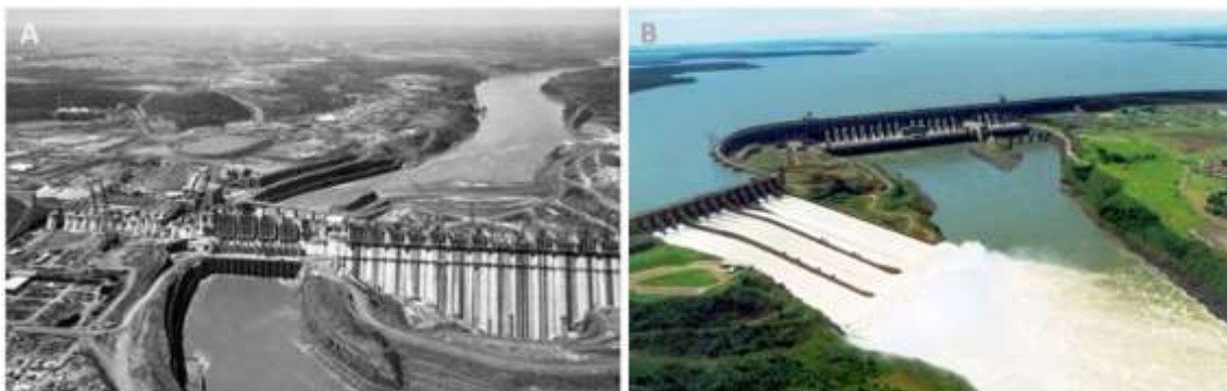
Figura 3. A) Desvio do rio Paraná durante a construção da barragem da Usina Hidrelétrica de Itaipu, em 1977. B) Hidrelétrica Itaipu Binacional, em 2009, com área alagada de 1.350 km 2 .
