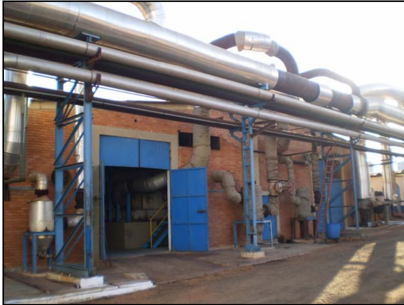
Figura 10: Central de distribuição de energia da usina. Usina Vale Verde - Itapaci, 13/05/2009. Foto: Lara Cristine Gomes Ferreira.
