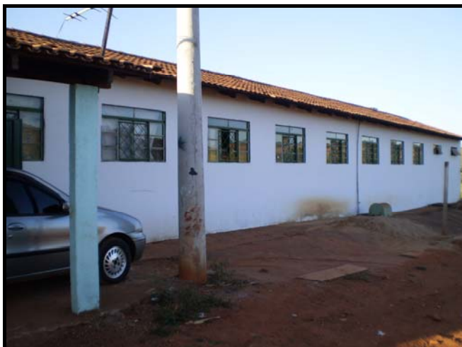
Figura 32: Entrada do alojamento mantido pela CRV Industrial. Carmo do Rio Verde, julho de 2009. Foto: Lara Cristine Gomes Ferreira.
