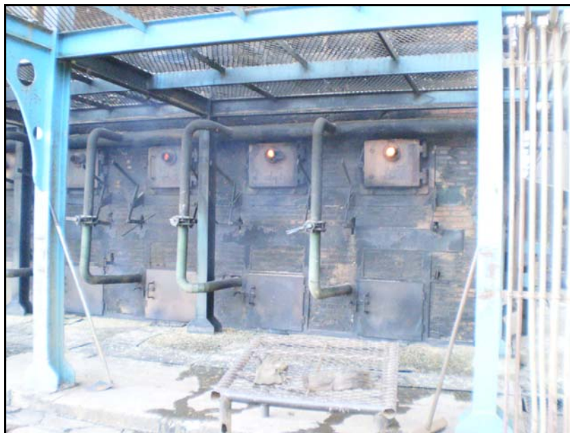
Figura 9: Caldeiras: incineração do bagaço da cana. Usina Vale Verde - Itapaci, 13/05/2009. Foto: Lara Cristine Gomes Ferreira.
