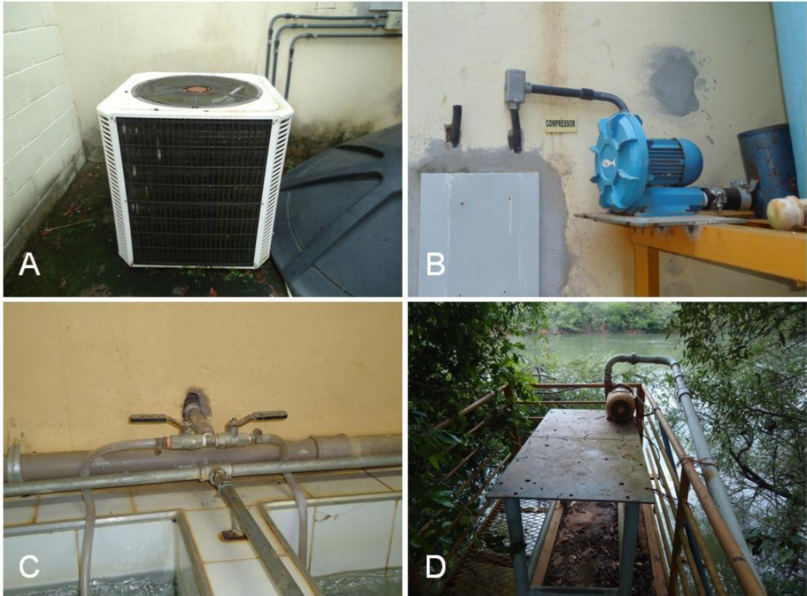
Figura 4. A) Aquecedor. B) Compressor. C) Tubos para a passagem do ar. D) Bomba de água.
