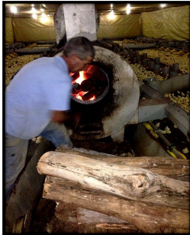
Figura 2. Montagem da campânula de aquecimento a lenha para frangos de corte. Fonte: Pazzini, 2013.
