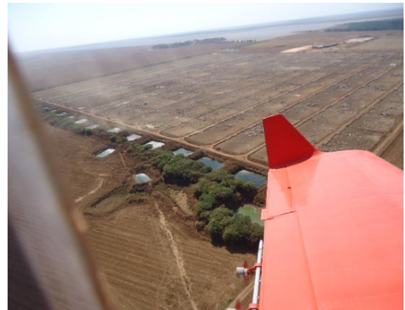
Figura 13. Vista aérea das lagoas de decantação. Fonte: Milton Perpétuo (2014).
