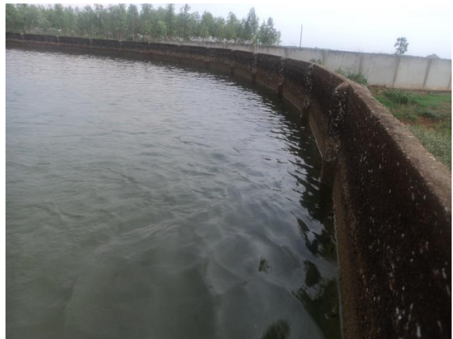
Figura 11. Reservatórios de concreto
