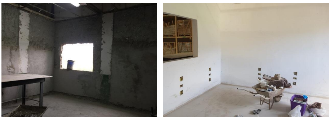
Figura 10. Reforma da sala controle de qualidade de Montes Claros de Goiás - GO
