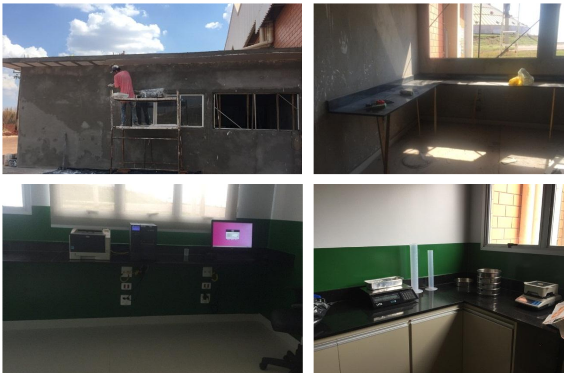
Figura 9. Construção da sala do controle de qualidade de Jataí-GO
