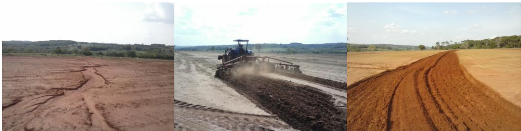
Figura 10. Processo de construção de curvas de nível para controle de erosão.
