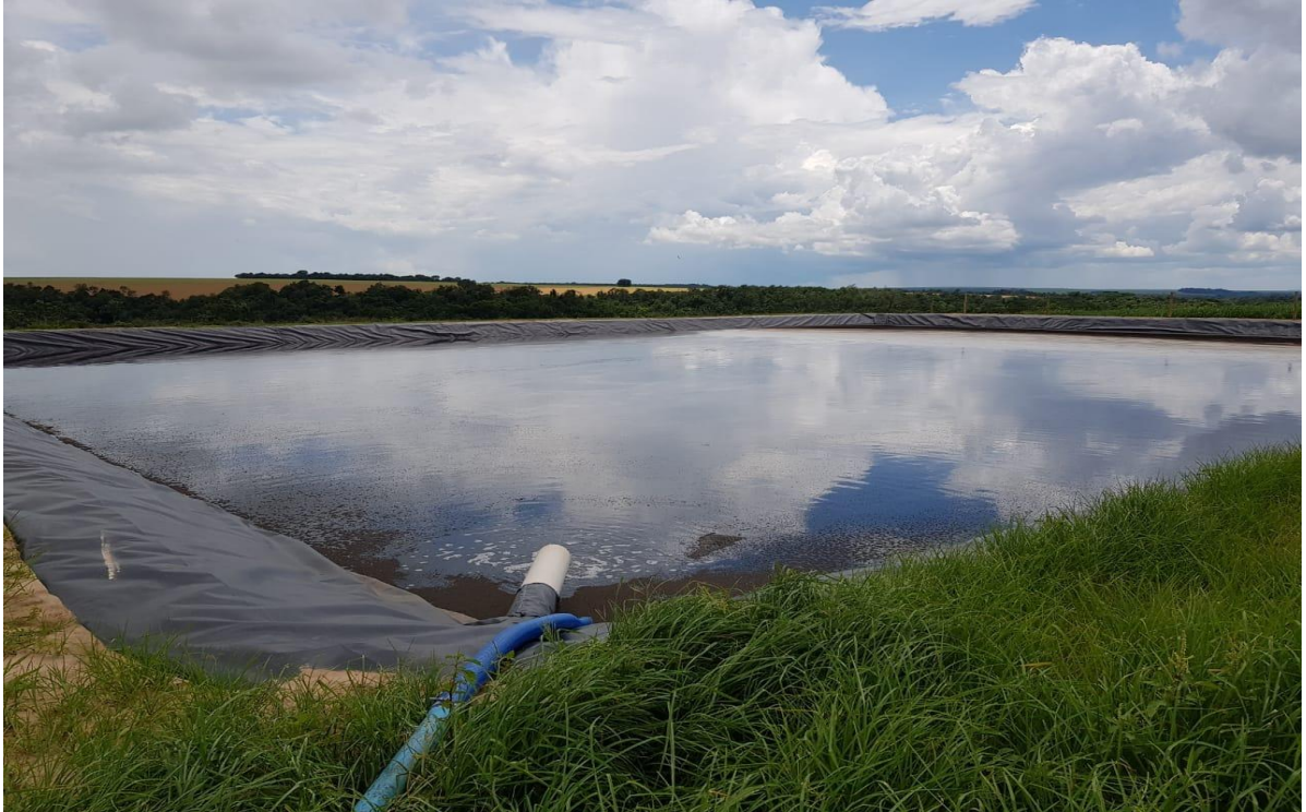
Figura 8. Lagoa de decantação utilizada na Fazenda Santa Maria, no município de Jataí-GO.
