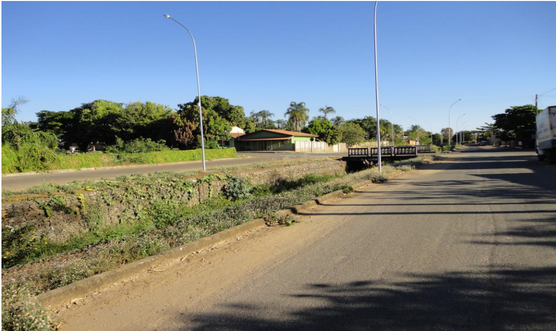
Figura 10 - Margens da avenida perimetral
