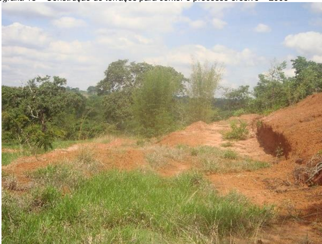
Fotografia 13 – Construção de terraços para conter o processo erosivo – 2006
