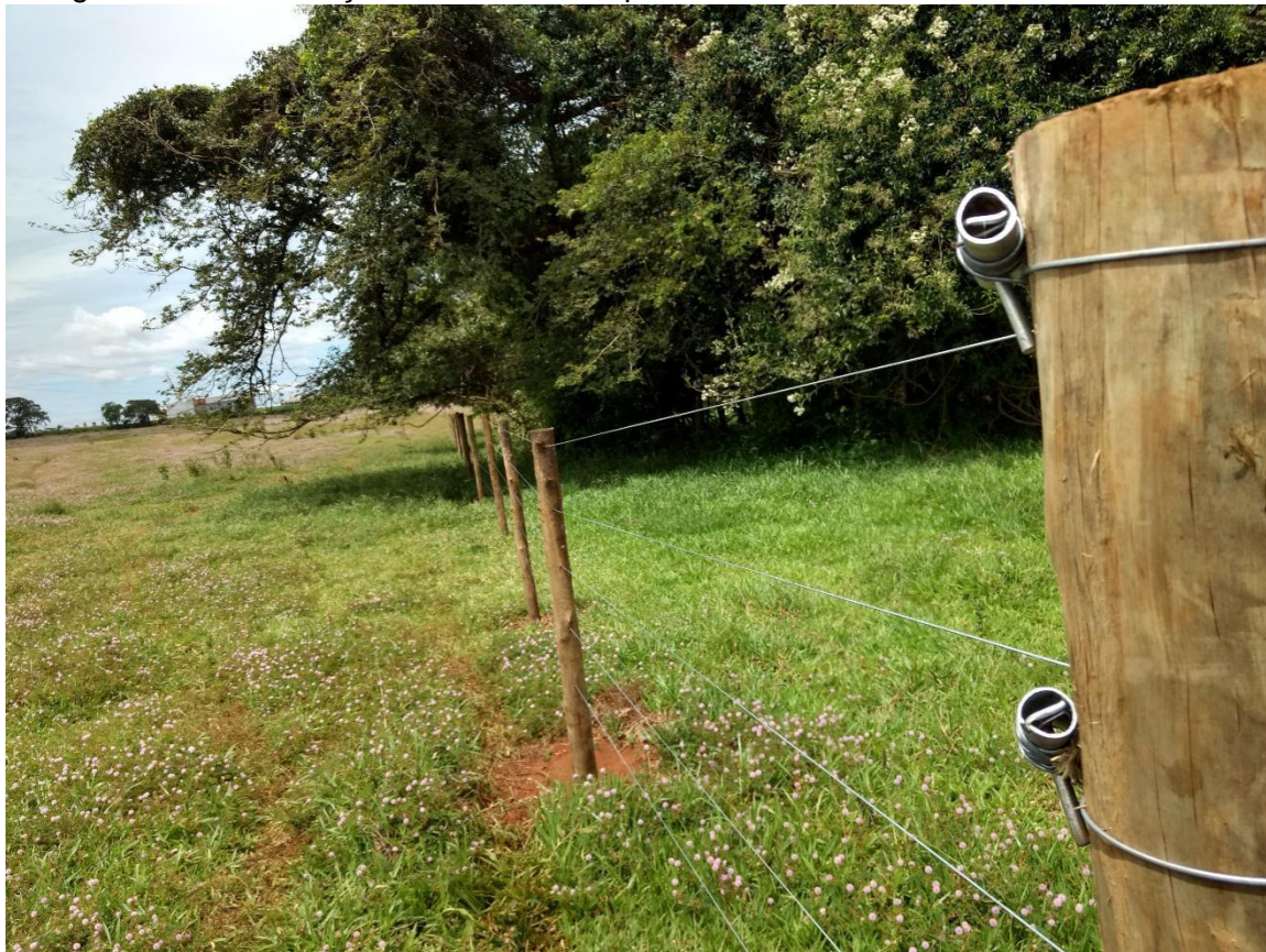
Fotografia 24 – Realização do cercamento pelo PPA – 2019
