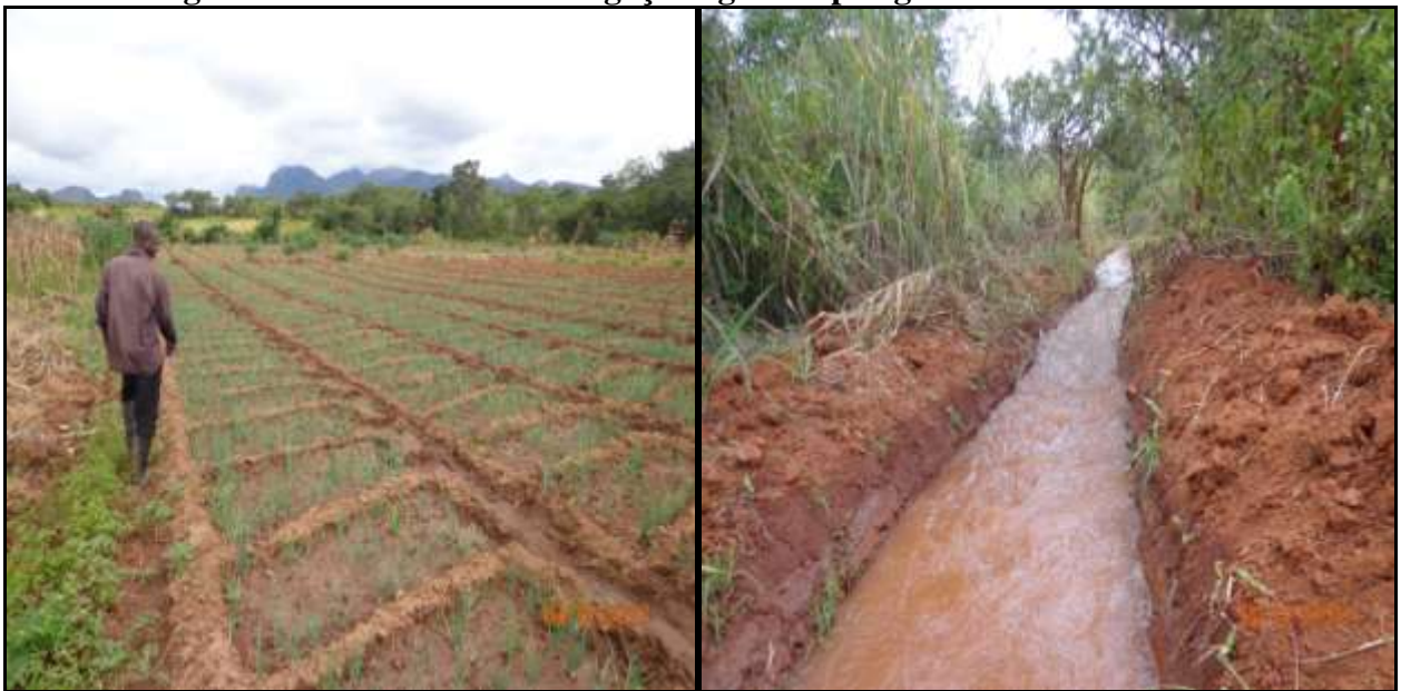
Figura 9 e 10 - Sistema de irrigação agrícola por gravidade em Malema
