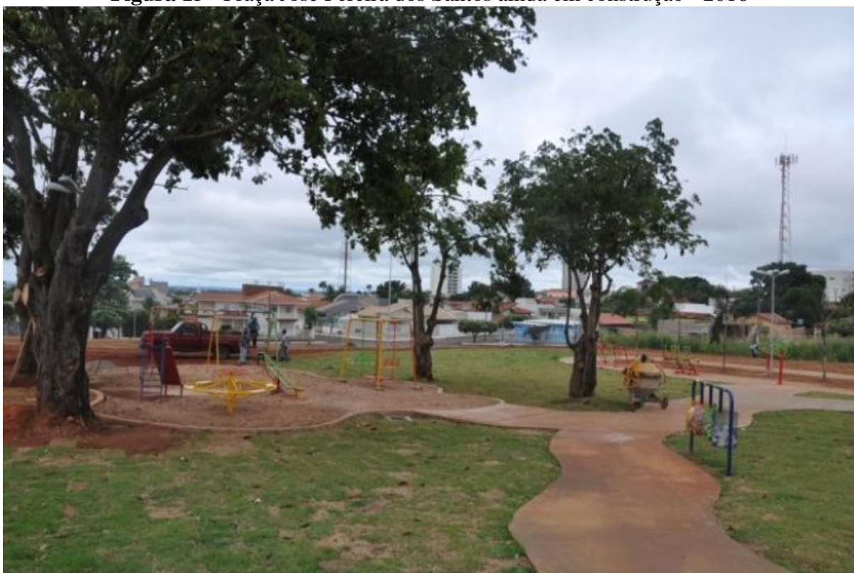
Figura 15 - Praça José Pereira dos Santos ainda em construção - 2016
