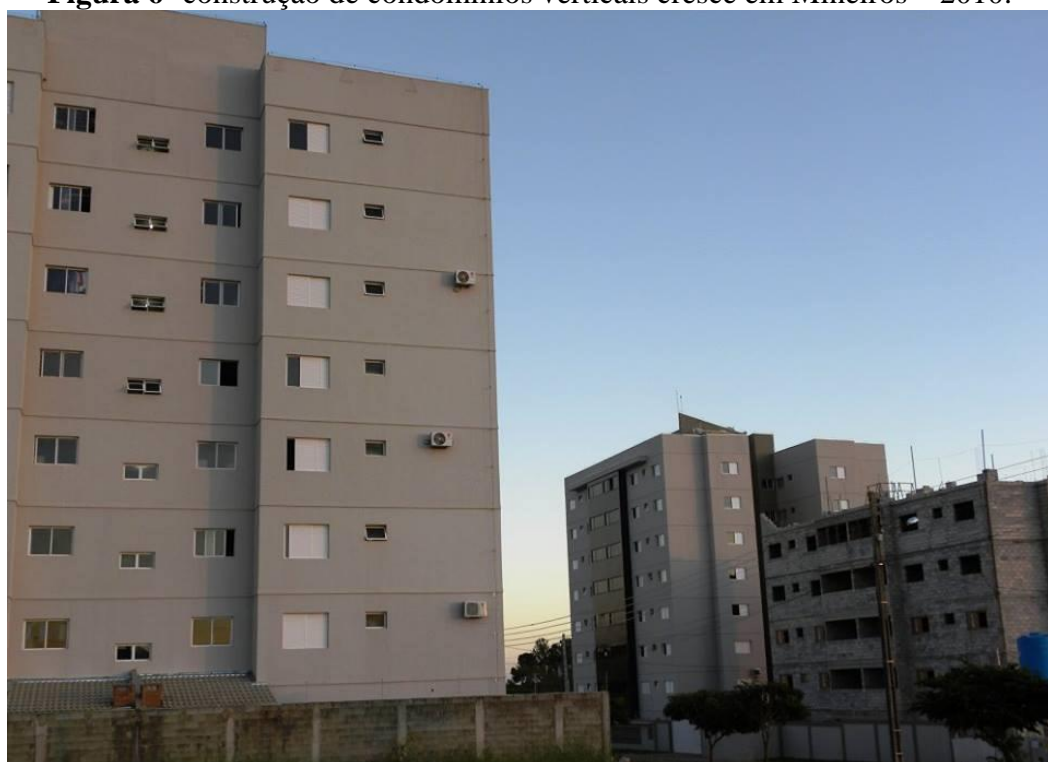
Figura 6- construção de condomínios verticais cresce em Mineiros – 2010.
