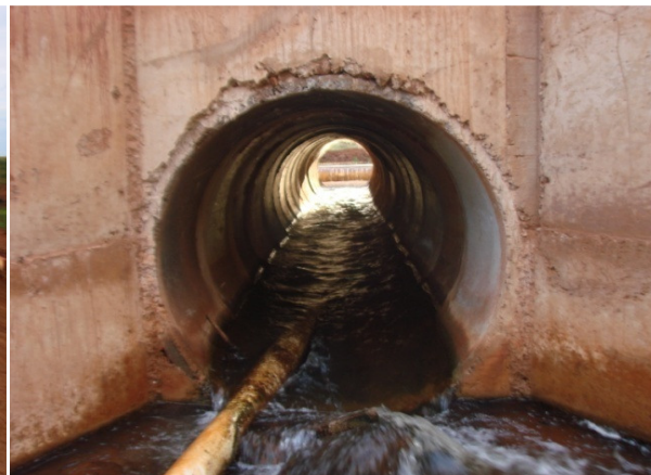
Foto 6 – Manilha no Córrego do Vau sob estrada vicinal.
