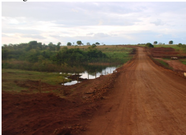
Foto 5 – Estrada vicinal cruzando o Córrego do Vau.
