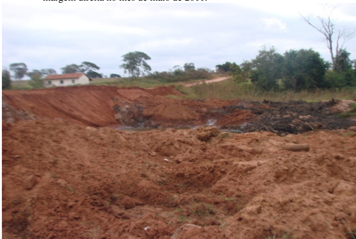
Foto 15 - Movimentação de terra para construção de bueiro no Córrego Coqueiro da margem direita no mês de maio de 2011.
