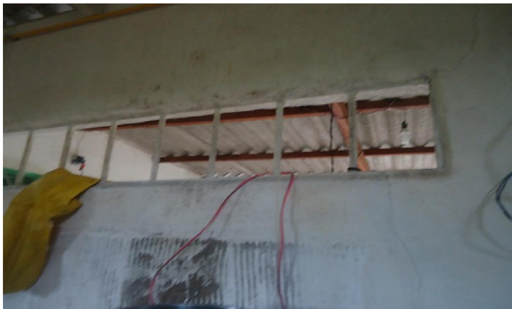
Figura 5 - Janela sem tela de proteção e sem vidro, rachadura, deformidades e sujeira na parede em estabelecimento produtor de queijo
