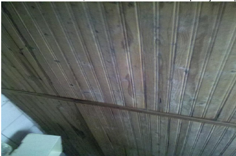
Figura 10 - Forro de madeira, com sinais de mofo em local de produção de queijo
