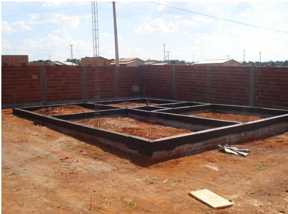
Figura 4.7 – Impermeabilização das vigas baldrame da casa 1
