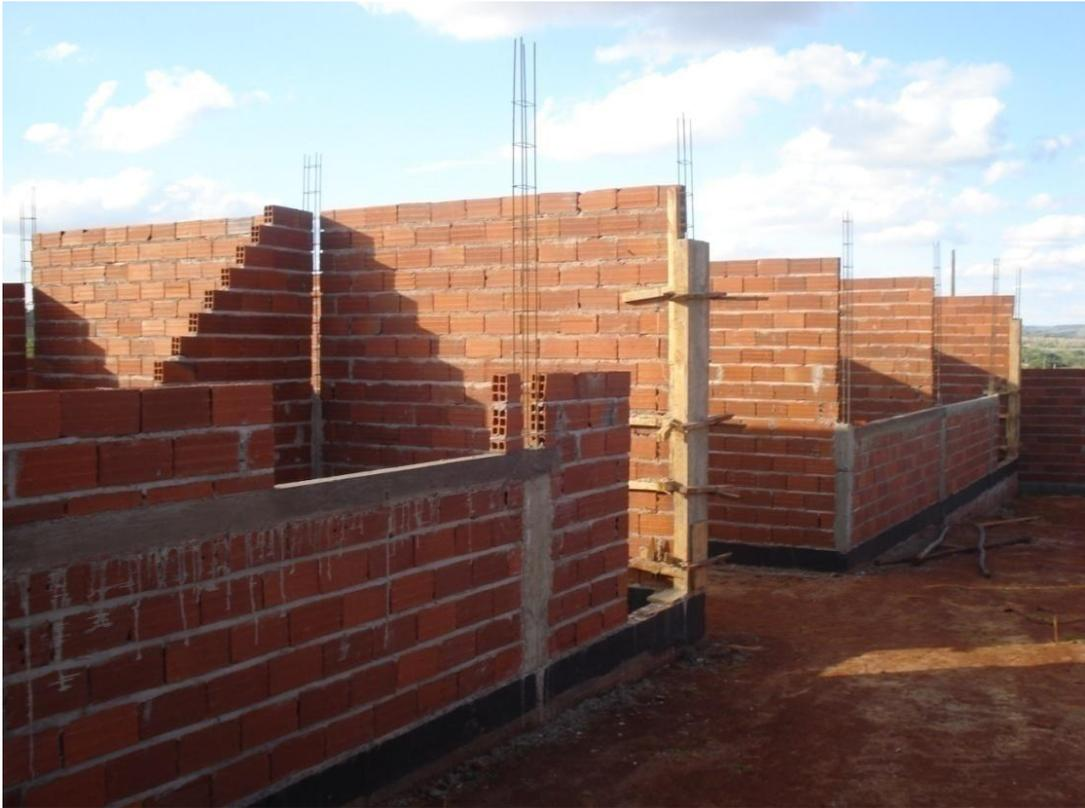
Figura 4.8 – Elevação da alvenaria das casas
