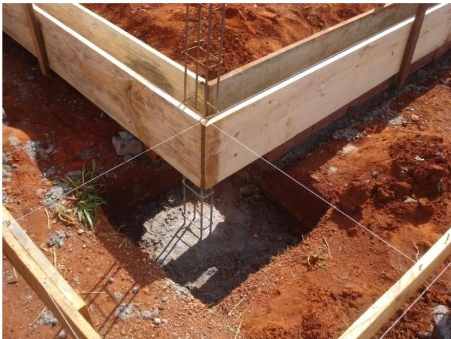
Figura 4.5 – Concretagem da fundação e execução das fôrmas das vigas baldrames
