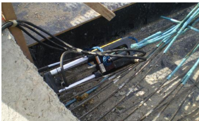
Figura 2.1 - Atuador hidráulico com pistões paralelos
