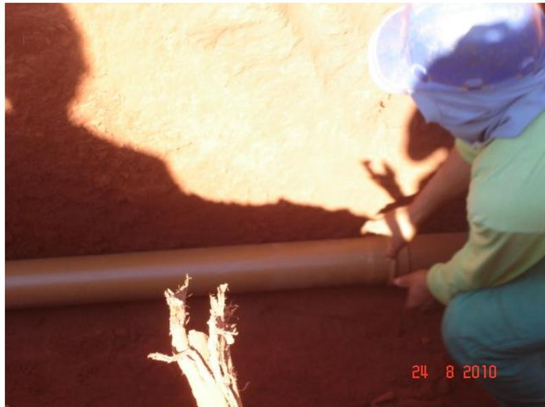
Figura 43 – Encaixe ponta e bolsa de tubulações
