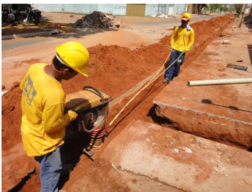
Figura 45 – Compactação mecânica
