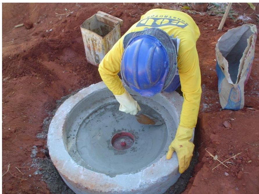
Figura 48 – Execução de anel com tampão
