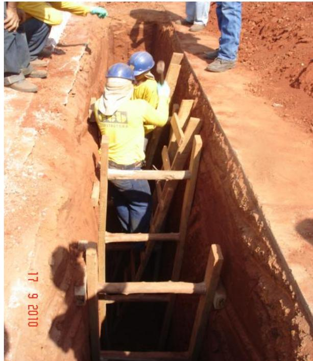
Figura 34 – Montagem de escoramento tipo pontaleamento
