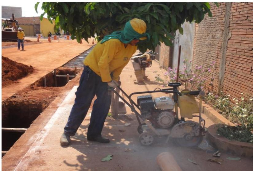
Figura 26 – Corte de calçada com “maquitão”
