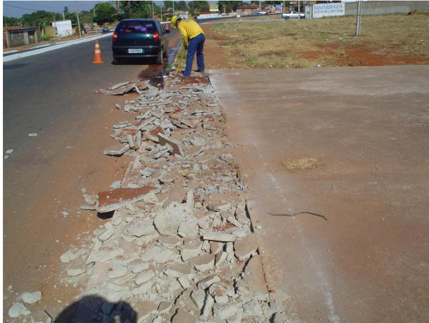
Figura 28 – Remoção de calçada com o uso de alavanca
