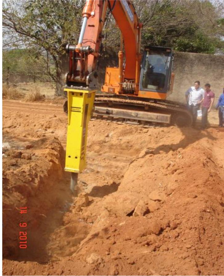
Figura 32 – Escavação em rocha com rompedor hidráulico
