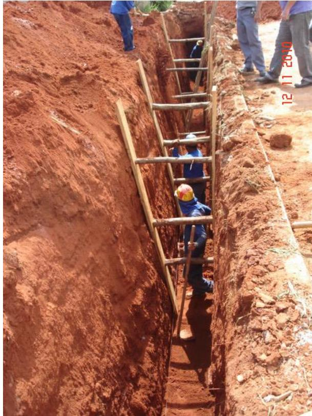
Figura 35 – Travamento dos pontaletes com o uso de estroncas
