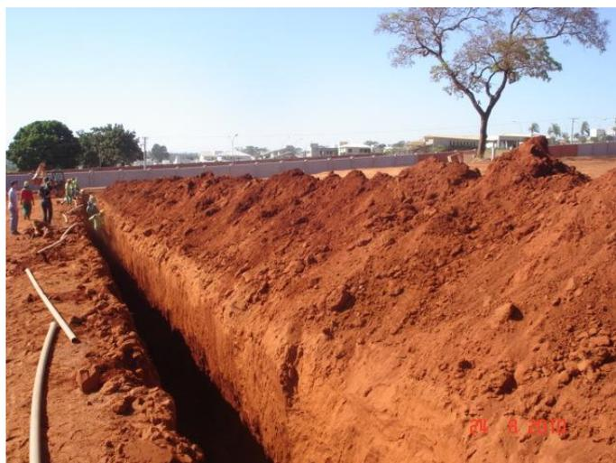
Figura 30 – Detalhe do solo colocado na lateral da vala, sem espaçamento mínimo
