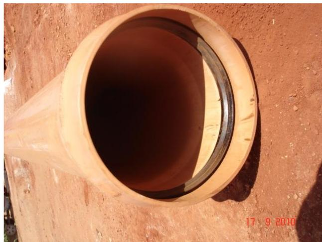
Figura 42 – Anel elástico utilizado em juntas de tubos PVC
