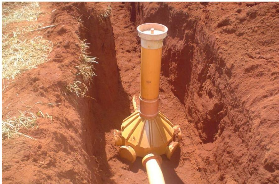
Figura 47 – Montagem de TIL radial com pescoço
