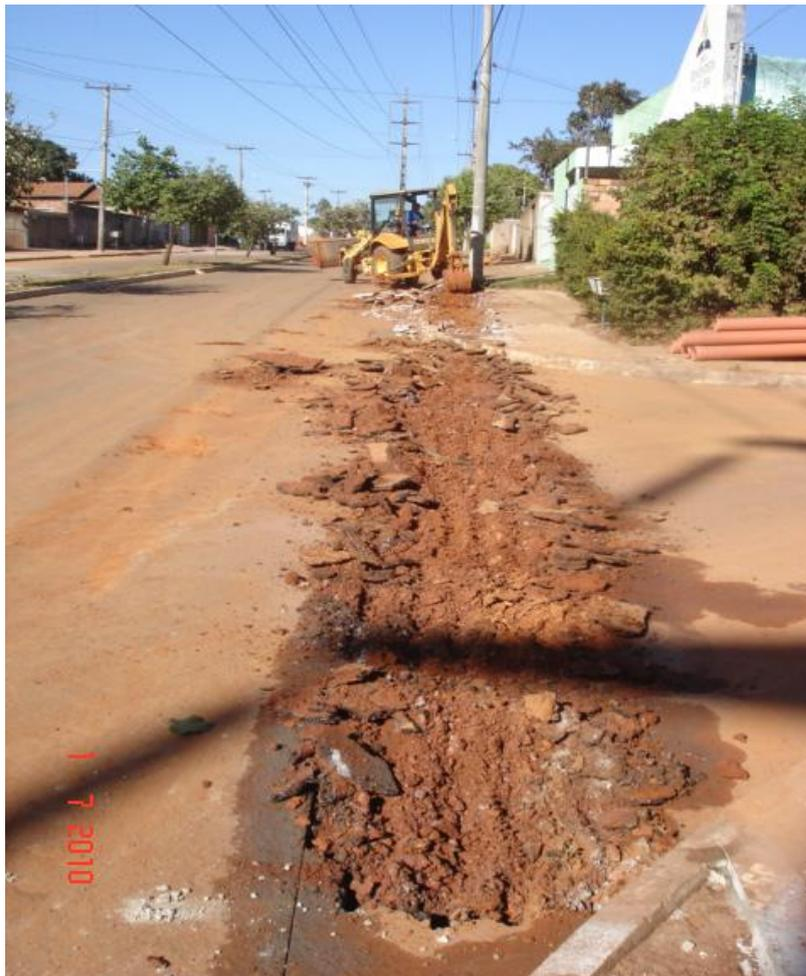
Figura 27 – Pavimento asfáltico rompido com o uso da retroescavadeira
