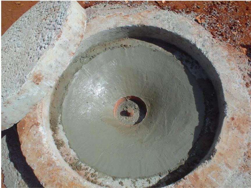
Figura 49 – Execução de anel com tampão
