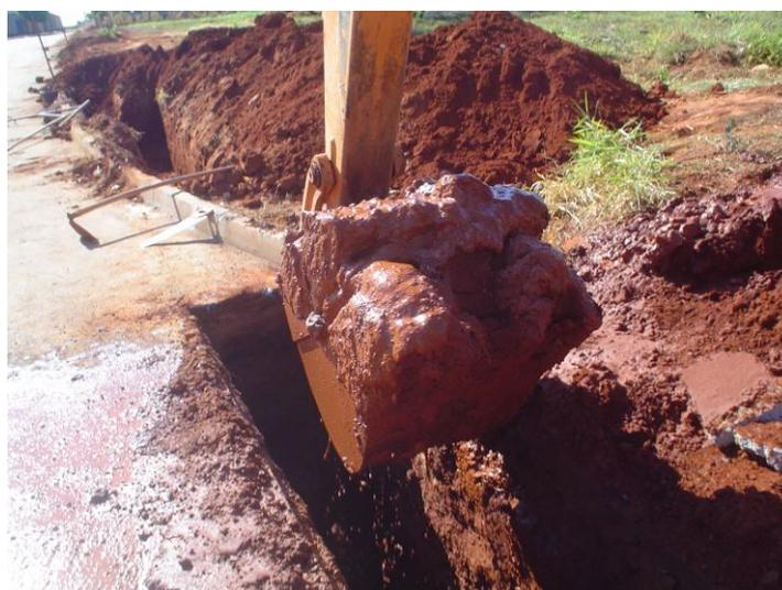
Figura 37 – Retirada de camada de solo de baixa resistência
