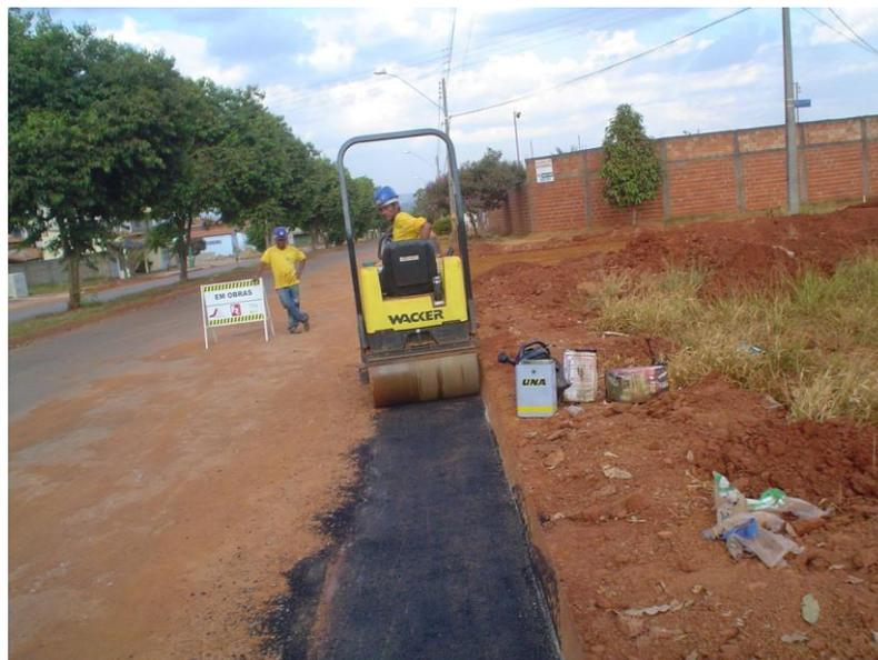
Figura 51 – Recomposição asfáltica
