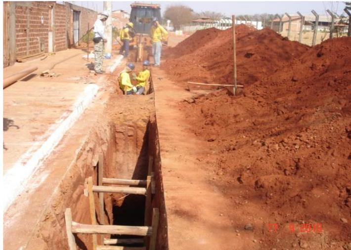
Figura 31 – Escavação de valas com damas para contenção do solo
