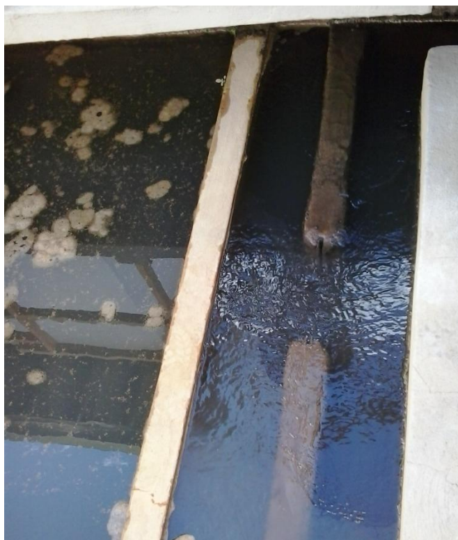
Figura 4.3 - Afogamento da entrada de água floculada para decantador
