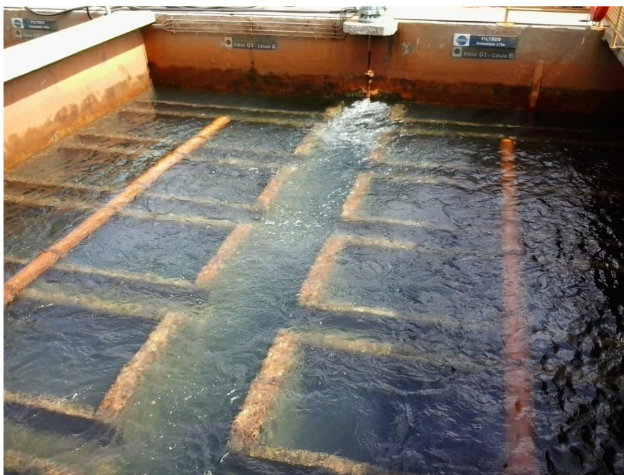
Figura 2.1 - Filtros rápidos descendentes em funcionamento na ETA Jaime Câmara
