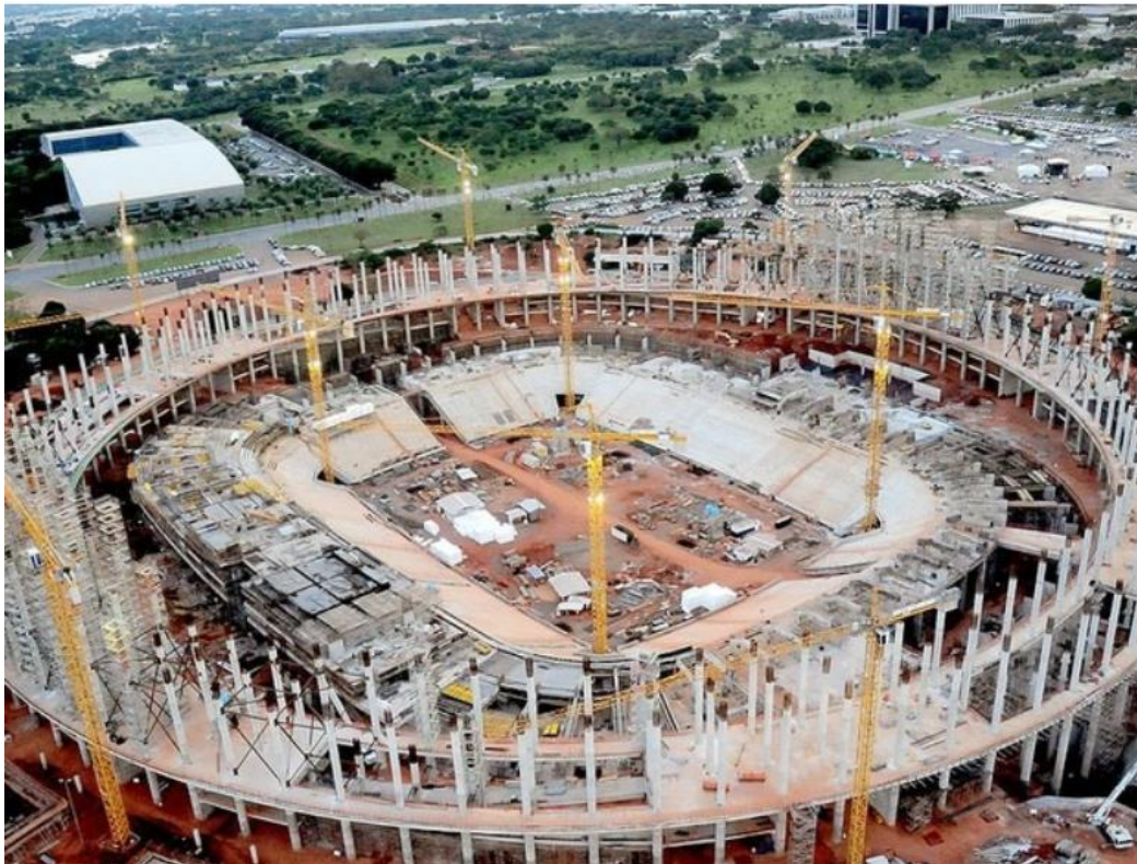
Figura 2.5 – Reconstrução do Estádio Nacional de Brasília
