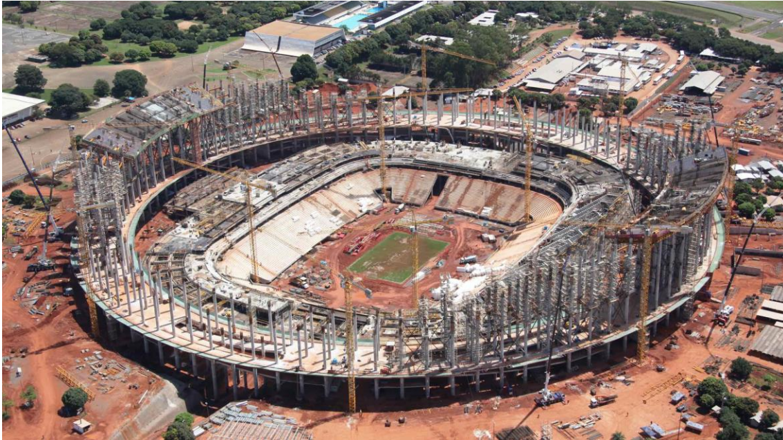
Figura 2.8 – Execução dos pilares externos e da arquibancada.
