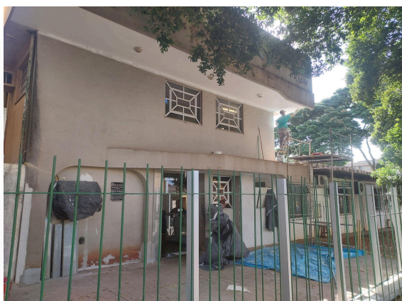
Imagem 35: Entrada do prédio do IV/UFG, durante a reforma
