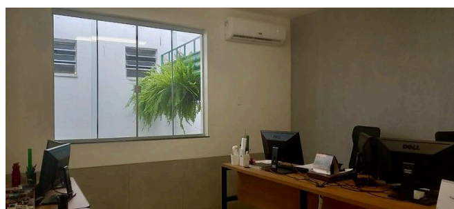
Imagem 25: Sala da Coordenação Financeira do IV/UFG, após reforma
