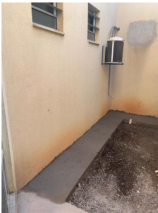
Imagem 26: Espaço de ventilação no térreo, antes da reforma
