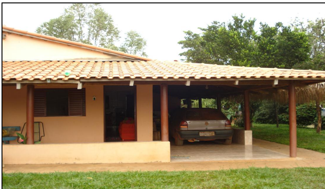
Foto 10 - Residência feita de alvenaria - Comunidade do Salgado – Município de Quirinópolis – GO
