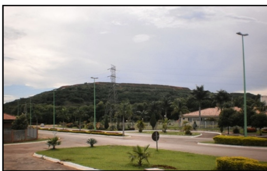
Figura 70: Taludes da banca B de estéril em 2012. Fonte: PEREIRA, 2012.
