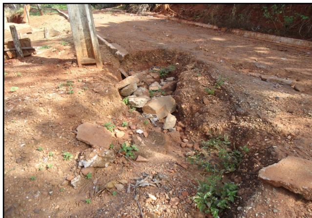
Figura 33: Deposição de Entulho para Conter Processo de Ravinamento. Fonte: PEREIRA, 2011.
