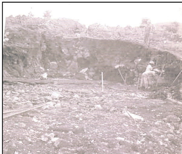
Figura 60: Fase de abertura da Cava A em 1966. Fonte: PAMPLONA, 2003.
