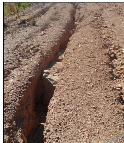
Figura 37: Processo de Ravinamento em Área de Aterro. Fonte: PEREIRA, 2011. Figura 38: Processos Erosivos Lineares em Área de Aterro. Fonte: PEREIRA, 2011.
