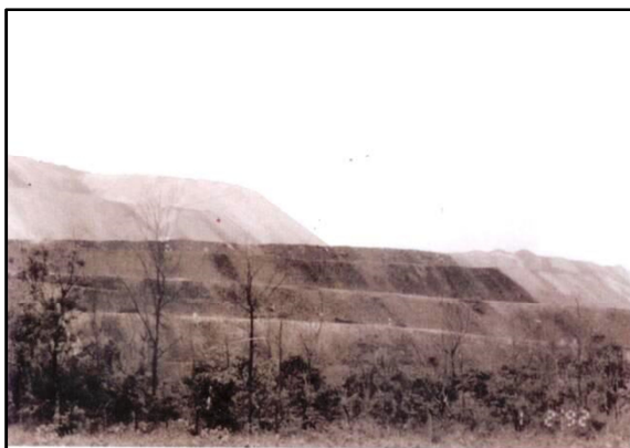
Figura 65: Construção dos primeiros taludes da Banca A em 1992. Fonte: PAMPLONA, 2003.
