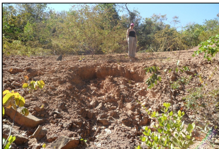
Figura 34: Processos Erosivos em Borda de Estrada. Fonte: PEREIRA, 2011.
