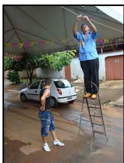
Figura 69 - Folião instalando material elétrico no toldo armado na rua no dia da entrega. Foto: Tito Coelho, 6 de janeiro de 2010.
