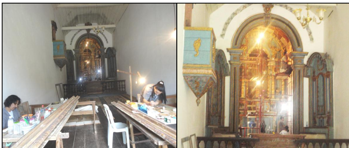
Figura 13: Processo de restauração dos altares, do forro e paredes da Igreja Nosso Senhor do Bonfim. Autor: Rangel G. Godinho (janeiro de 2012).
