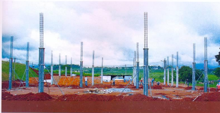
Obra de construção das unidades fabris em andamento no Pólo Têxtil
