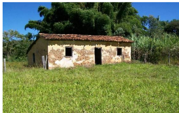
Figura 10: Casa abandonada em terras arrendadas. Fonte: Teixeira (2009).
