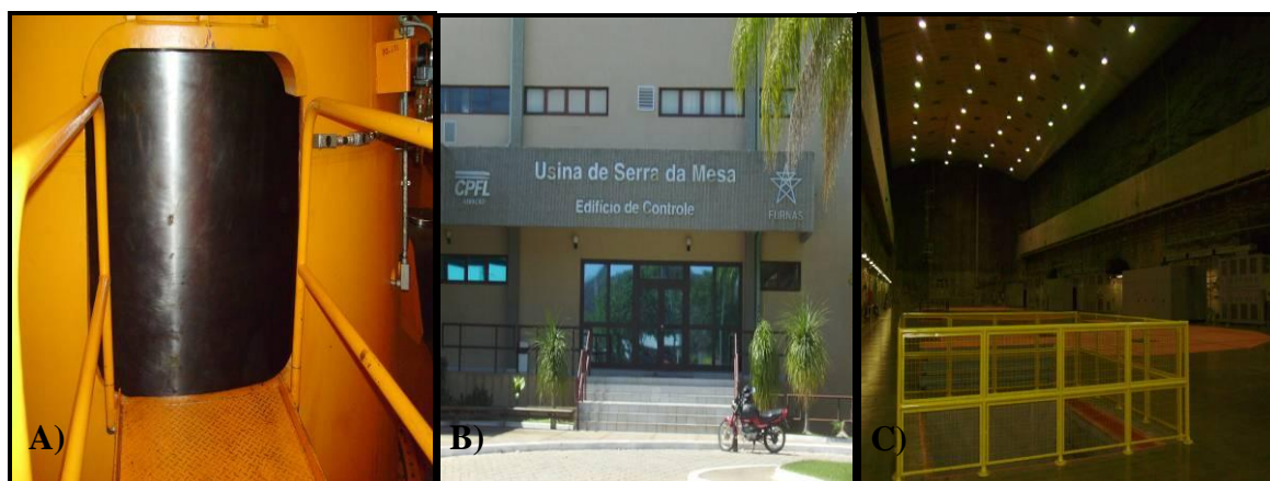
Figura 27: (A) Foto da Turbina Francis; (B) Foto da entrada da Usina de Serra da Mesa; (C) Foto do galpão que dá acesso a casa de Força da Usina de Serra da Mesa
