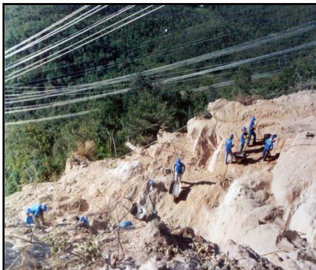
Figura 30: Foto de trabalhadores nas obras de Furnas na área da Reserva Indígena
