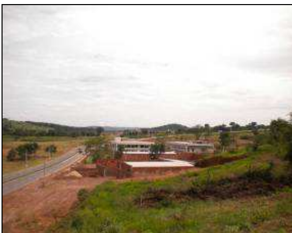
Foto 26 – Zona Industrial na Região Galvão (I), 2009.
