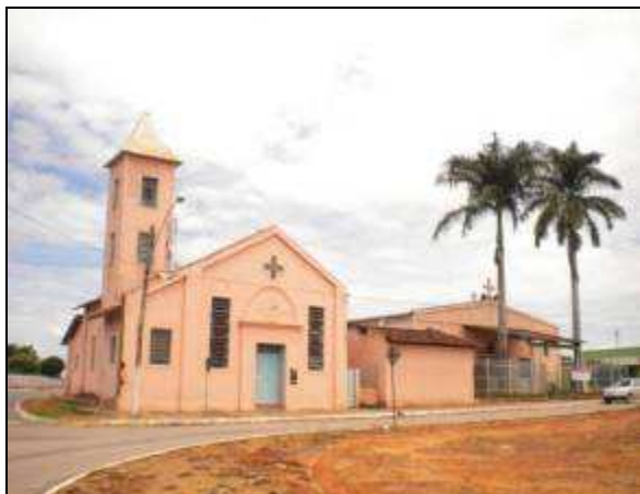
Foto 06 – Igreja Matriz – Segundo equipamento urbano mais importante da história da centralidade do Distrito de Senador Canedo, 2009.
