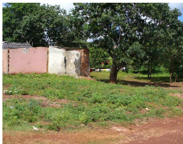
Figura 49 - Vista da invasão do bairro Jardim Guanabara II. Aparecem na foto às paredes que sobraram das casas dos moradores transferidos, as mesmas ainda sustentam os barracos ainda existentes no local. A direita pode ser observada a rua improvisada pelos moradores para chegarem as suas residências.
