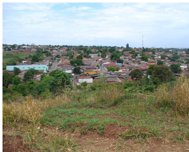
Figura 53 - Visão panorâmica dos bairros da porção sul da bacia, que estão amplamente urbanizados.
