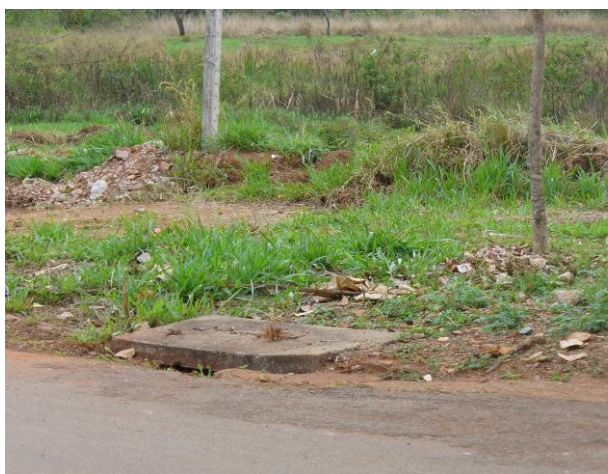
Figura 48 - Bueiro no bairro Guanabara II. Apesar de existirem bueiros no bairro, estes são precários.
