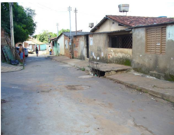
Figura 46 - Invasão Guanabara II. Detalhe: o bueiro muito grande que denota a quantidade de fluxo que passa por essa rua.
