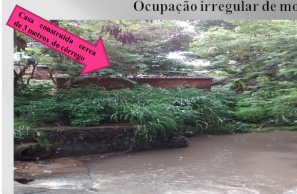
Figura 18: Pimenta, 2015. Risco de inundação iminente em casa construída a poucos metros do córrego Botafogo. Vila Nonato Mota, Vila Redenção, Goiânia-GO.
