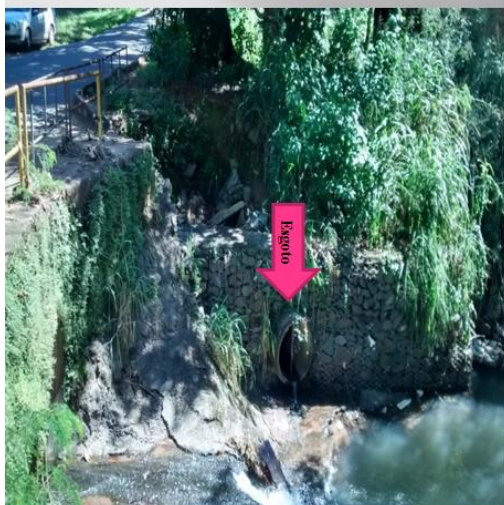
Figura 12: Pimenta, 2015. Tubulações denunciando a poluição do córrego Botafogo. Presença de água turva na Viela Nonato Mota, Vila Redenção, Goiânia-GO.
