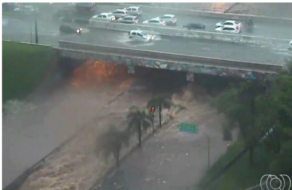
Figura 29: inundação no trecho da Marginal Botafogo com a Avenida Universitária
