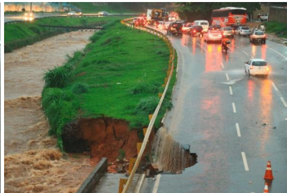
Figura 30: Solapamento da parede de concreto na Marginal Botafogo
