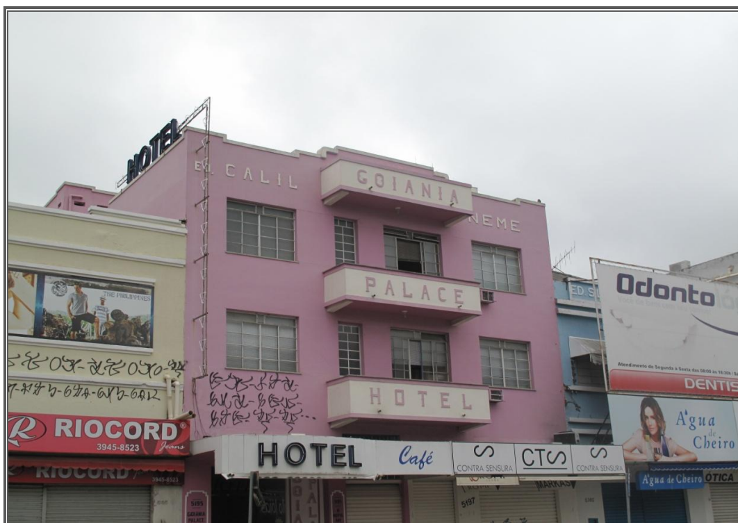
Figura 37: Poluição visual em edifício art déco – Av Anhanguera, Centro de Goiânia
