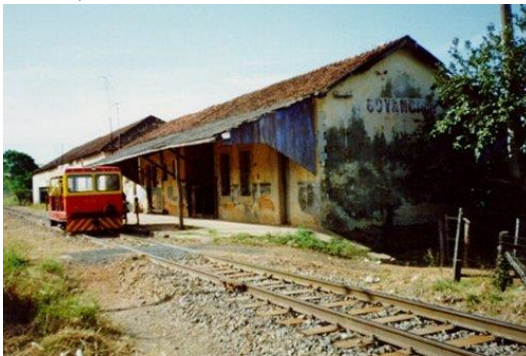
Fotografia 11: Estações Ferroviárias em Goiandira e Catalão, Goiás.
