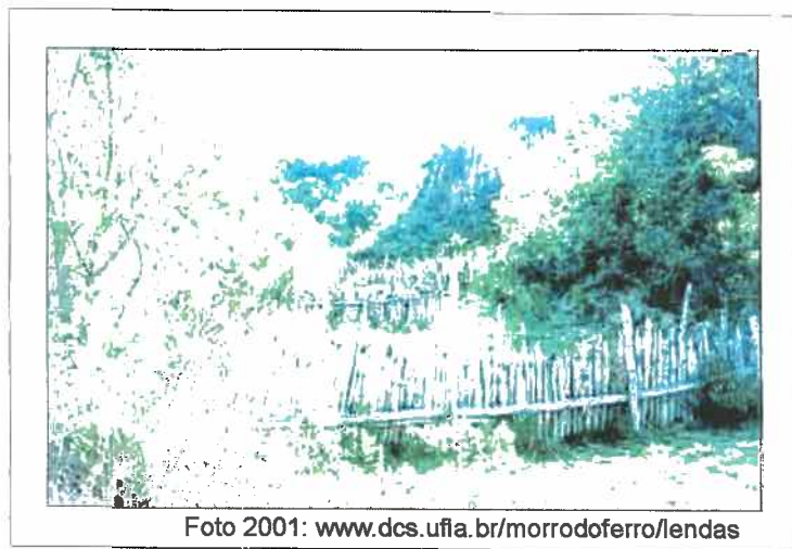
Foto 24 a: Construção de sucessivas paliçadas de bambú no interior da boçoroca.
