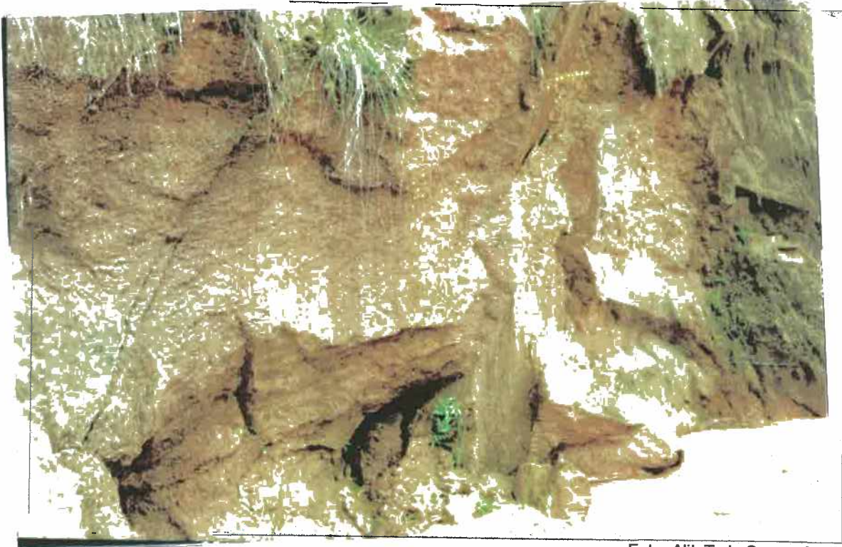
Foto 6: Piping na base do talude; horizonte C representado pelo migmatito alterado, apresentando planos de fraqueza e / ou fraturas.
