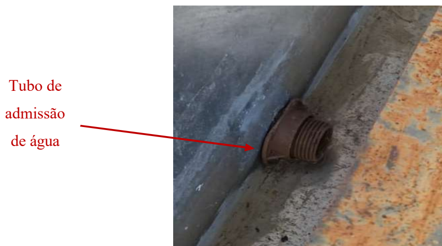
Figura 02 – Detalhe da fixação interna do tubo.
